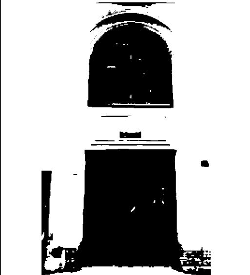
профицированный наличник, объединяющий дверной проем, ведущий в вестибюль парадной лестницы и оконный проем с полуциркульным завершением в уровне второго этажа;
