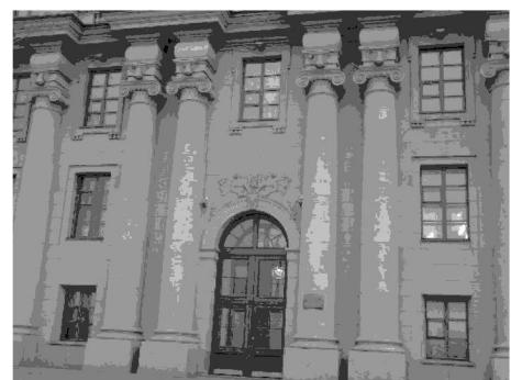
местоположение, габариты и конфигурация дверных проемов, в т.ч. в форме полуциркульной арки входной проем Л-2 и вписанный в нишу с полуциркульным завершением проем Л-1;
