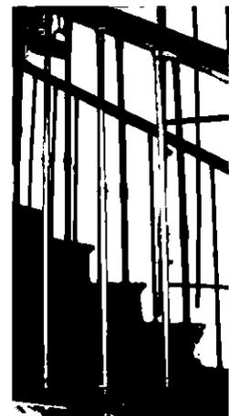
лестницы западного и восточного фланкирующих объемов - местоположение, тип (трехмаршевые), конструкция (марши на ползучих арках с забежными ступенями, площадки на коробовых сводах); материал (известняк) и профиль ступеней;
