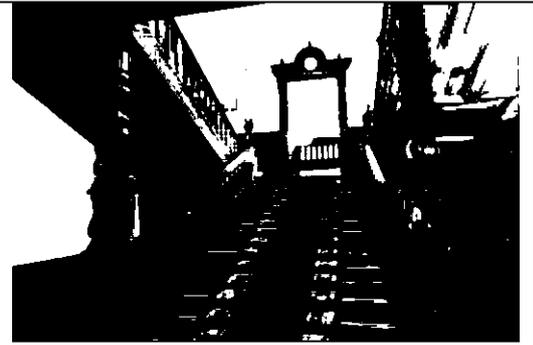
лестница правой части вестибюля основного объема - местоположение, габариты, тип (двухмаршевая), конструкция (марши на металлических клепаных косоурах, площадки на металлических клепаных фермах); материал ступеней – дерево, металл (основание ступеней); ограждение – материал (металл), техника исполнения (литье), рисунок (вертикальные фигурные стойки круглого сечения);
