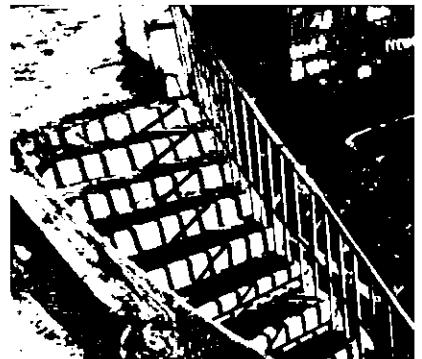
лестниц спусков внешней торцевой причальной стенки дока - местоположение, габариты, тип (маршевые), материал ступеней и обкладки лестниц - плиты из гранита, металлическое ограждение лестниц;
