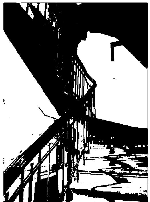
ограждение лестницы – материал (металл), рисунок (кованые секции с геометрическим рисунком), поручни – дерево, профиль;
