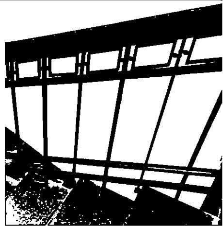
лестница Л2 – местоположение, конструкция (на косоурах), тип (двухмаршевая с забежными ступенями), габариты, материал ступеней (известняк);
