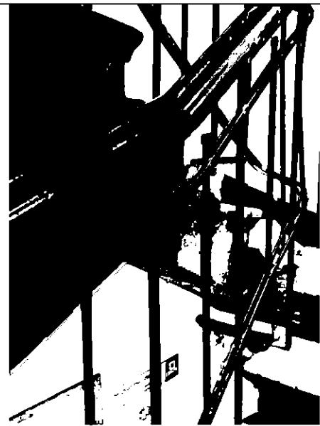
лестница ЛЗ – местоположение, конструкция (на косоурах), тип (двухмаршевая с забежными ступенями), габариты, материал ступеней (известняк);
