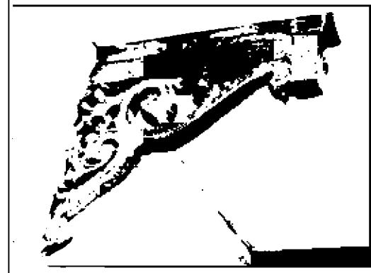
ограждение балкона – материал (металл), техника исполнения (литъе), оформление (угловые столбы круглого сечения с фигурными завершениями, овальные стойки заполнения, соединенные поясом кружков и разделенных в верхней и нижней части стилизованными фигурными ветвями, с вписанными в центральной части стилизованными буквами: заглавной «М» и малой «А»).
