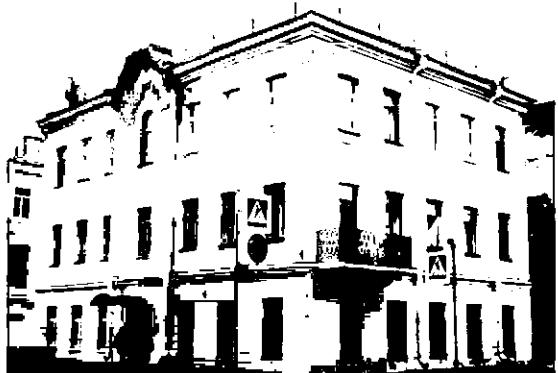
оформление оконных проемов оштукатуренными замковыми камнями в уровне первого этажа, подоконными прямоугольными нишами (проемы первого этажа) и оштукатуренными подоконными панелями (проемы второго-третьего этажей);
