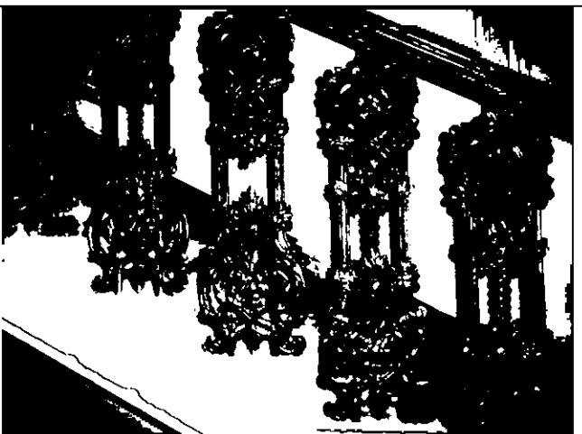
5-ЛК – двухмаршевую, на косоурах, с известняковыми ступенями, с металлическим ограждением из ажурных чугунных литых стоек, декорированных листом аканта, в поворотных частях стойки-балисины, с профилированным деревянным поручнем;
