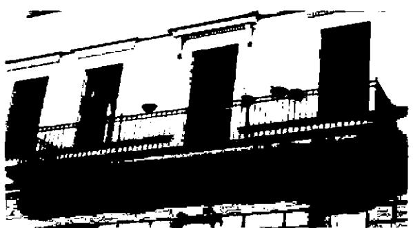
дверной (балконный) проем – местоположение, габариты, конфигурация, оформление – профилированный наличник с линейным сандриком с дентикулами, на волютообразных кронштейнах; исторический рисунок и цвет заполнения дверного (балконного) проема:
