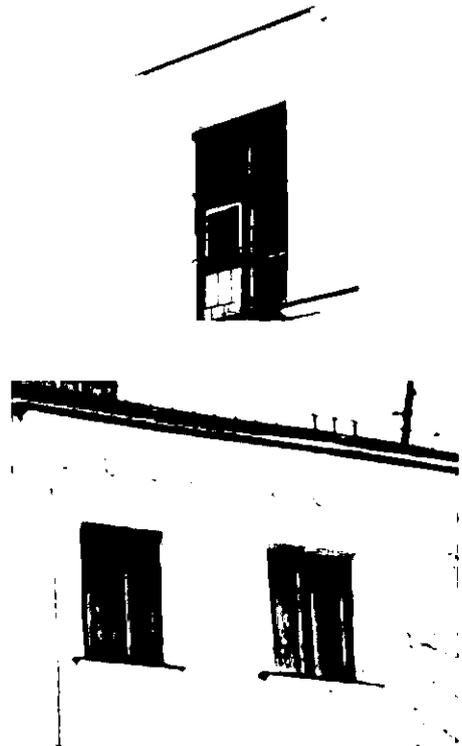
оформление оконных проемов 3 этажа по 4-16 осям – подоконные доски на кронштейнах;
