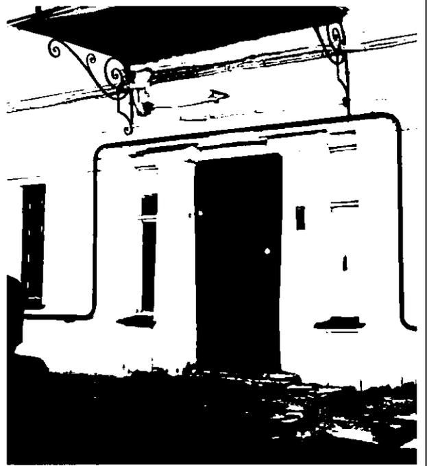
оформление оконных проемов 1 этажа по 4 и 5, 6 и 7, 10 и 11, 12 и 13 осям – профилированные наличники, линейные сандрики, веерные замковые камни;
