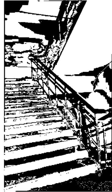
лестница переходной трехэтажной части здания в выступе – конструкция (по косоурам), ступени – материал (известняк), профиль, габариты; ограждения – материал (металл), техника исполнения (прокат, клепка), рисунок (прямые стойки);
