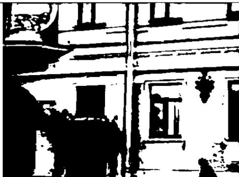
металлодекор: два кованых металлических флагодержателя, кованый козырек на кронштейнах над входным проемом парадной лестницы;
