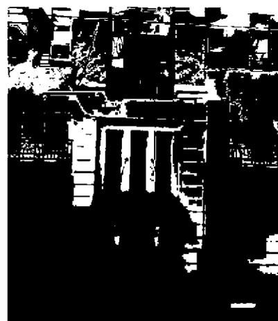
над входом козырек черного металла полуциркульный в плане, на ажурных кронштейнах черного металла с водостоками; рисунок растительного характера; техника исполнения (ковка, прокат, слесарная сборка);
