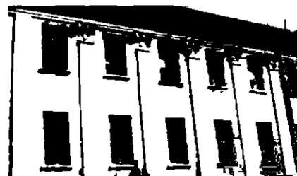
штукатурное профилированное оформление оконных проемов второго этажа с треугольными сандриками на волнообразных кронштейнах, подоконными выступами и нишами с профилированными декоративными полотенцами по 8 – 12 осям фасада;
