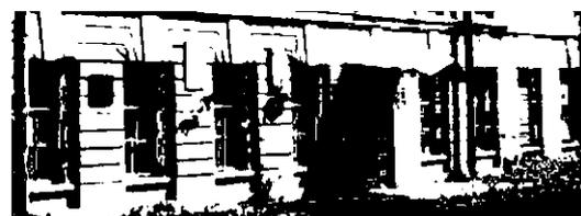
оформление оконных и дверного проемов штукатурными замковыми камнями в уровне первого этажа по 6 – 14 осям фасада;
