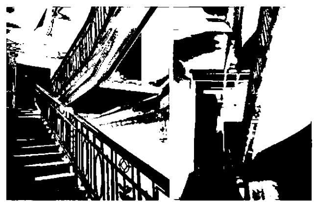
ограждение – материал (металл), рисунок (выполнены в стиле модерн, секции из вертикальных стоек с элементами растительного и геометрического рисунка), поручни (деревянные, профилированные);
