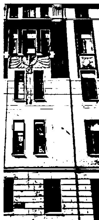
венчающий карниз с большим выносом, в нижней части фриза порезка «ионики»;
