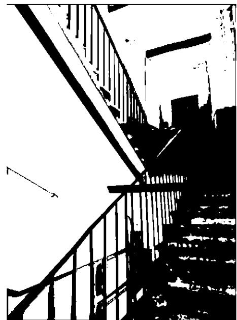
лестница Л-6 – местоположение, габариты и конструкция (по косоурам), материал ступеней (известняк), материал лестничных ограждений (металл, рисунок (вертикальные стойки, поручни - металл);
