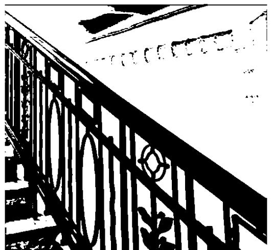
лестница Л-4 – местоположение, габариты и конструкция (по косоурам), материал ступеней (известняк), материал лестничных ограждений (металл, рисунок (вертикальные стойки, поручни – металл);
