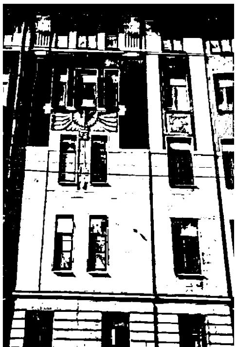
четыре трехгранных эркера на уровне 3-4-го этажей завершенные балконами, расположенные в уровне 5-го этажа – местоположение, конфигурация (трапециевидная форма), габариты;
