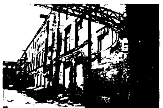
оформление тимпана треугольного фронтона прямоугольными нишами по сторонам круглого оконного проема с датой строительства корпуса – «ГОДЬ» «1914», выполненной выпускным кирпичом;
