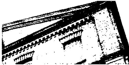
оформление ризалитов лопатками и аттиковыми стенками с карнизом и поясом дентикул; парапетная стенка с угловыми тумбами.
