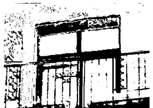
балконы – местоположение (в уровне 3-го, 5-го этажей, в завершении эркера), габариты, конфигурация (прямоугольные в завершении эркеров, прямоугольные с вогнутыми углами), конструкция (на металлических кронштейнах, на металлических балках):
