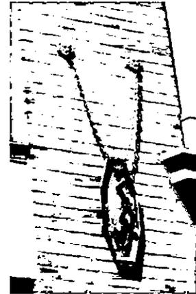
фонарь – местоположение (центральная часть воротного проезда), конструкция (подвесной, в форме сложного многогранника), способ крепления (на центральной цепи и растяжках), вид материала (черный металл), техника исполнения (ковка);
