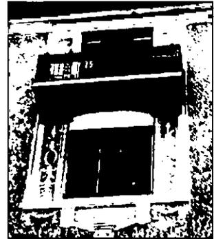
под оконным проемом расположена филенка в профилированной раме с цифрами «1912» под профилированным карнизом, фланкируемая провисающими гирляндами, под оконным проемом;
