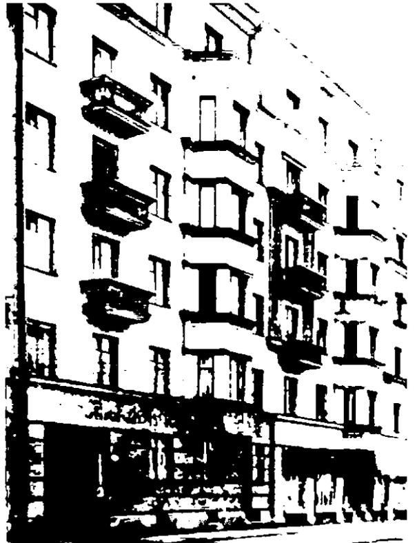
эркеры оформлены прямоугольными и фигурными филенками в подоконном пространстве и подшивках, с междуэтажными карнизами, профилированными тягами над оконными проемами и венчающими карнизами;
