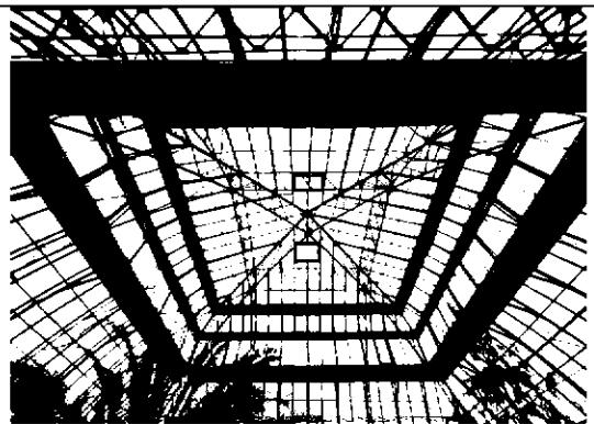
обходной эксплуатационный подвесной ходовой мостик с ограждением и лестницей – местоположение (по периметру центрального шатра), деревянный настил, конфигурация, материал (металл); конструкция крепления мостиков (подвесные металлические клепаные прогоны и решетки);
