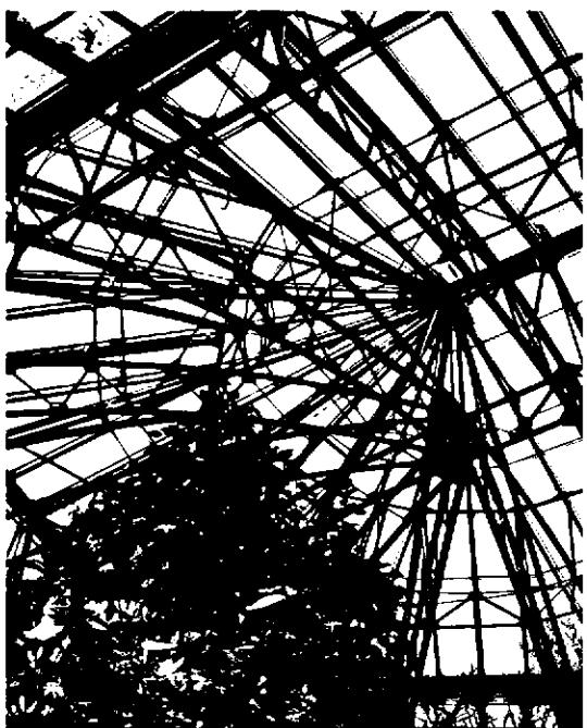
историческая металлическая стропильная система на клепанных соединениях четырехскатного перекрытия на двух пересекающихся ребер прогона с треугольной раскосой решеткой и узлами соединения – шаг, местоположение, конструкция, материал, узлы соединения;
