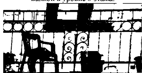
Ограждение балкона в уровне 3-го этажа.
