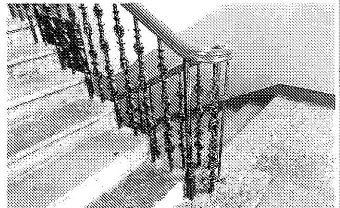
лестницу дворового корпуса - маршевую, с площадками по прусским сводам, со ступенями и площадками из известняка, металлическим кованым ограждением в виде вертикальных прутьев круглого сечения с металлическим поручнем;
