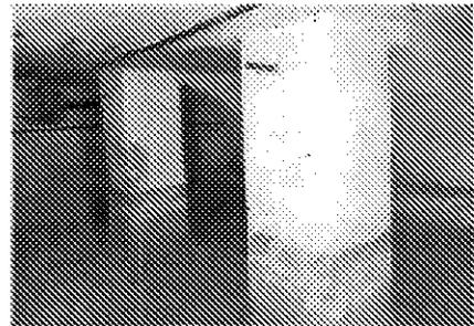
воротный проезд перекрыт коробовым с распалубками, на подпружных арках сводом;
