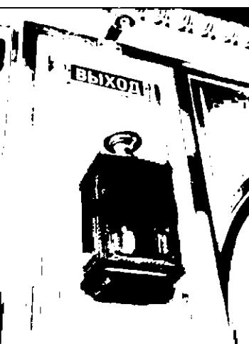
8 ед., обогревательные приборы, тумбы круглого сечения в виде стволов, в нижней части в плане – правильный восьмигранник с решетками просечного металла. В верхней части корпуса – пластины металлические, радиально расположенные. Чугунолитейный и механический завод Ф.К.Сан-Галли.
