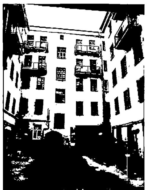
местоположение, габариты, конфигурация (с прямой перемычкой) исторических оконных проемов в уровне 2-го - 5-го этажей; отметки высоты, габариты ширины оконных проемов в уровне первого этажа; исторический рисунок расстекловки, единообразное колористическое решение; профилированный венчающий карниз.
