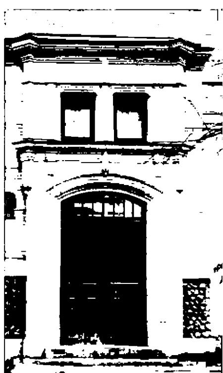
в завершении фасадов сложнопрофилированный карниз значительного выноса; парапетное ограждение с металлическим окрытием; аттиковые надстройки;
