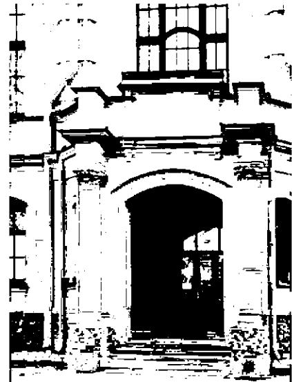
дверное заполнение – двустворчатое с двумя боковыми нестворными частями; створки полусветные; фрамуга светлая с полуциркульной перемычкой; рисунок фрамуги (вертикальная четырехчастная расстекловка); материал (дерево);
