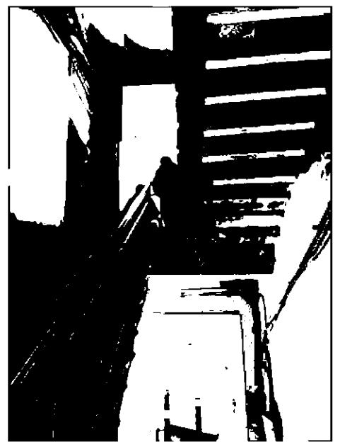
ограждения маршей черного металла в виде вертикальных стержней прямоугольного сечения с круглыми завершениями; техника исполнения (прокат, слесарная сборка);
