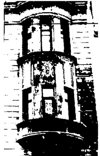
два полуциркульных в плане эркера, в уровне 3-4-го этажей, в крайних световых осях, оформленные пилястрами ионического ордера в межконных простенках 4-го этажа, декоративными панно и гирляндами между этажами;
