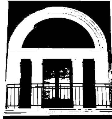
ограждение балкона – материал (металл), рисунок (вертикальные стойки);
