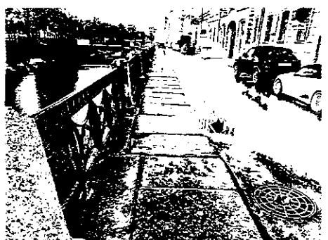
левый берег (от набережной Крюкова канала до 2-го моста Круштейна) – набережная полууткосного типа, низкая банкетная стенка, облицованная гранитными блоками и гранитными накрывочными плитами.
