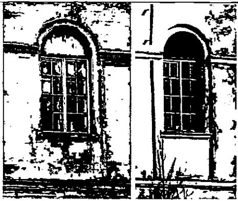
оформление оконных проемов третьего этажа оштукатуренными наличниками и кирличными веерными выкладками;
