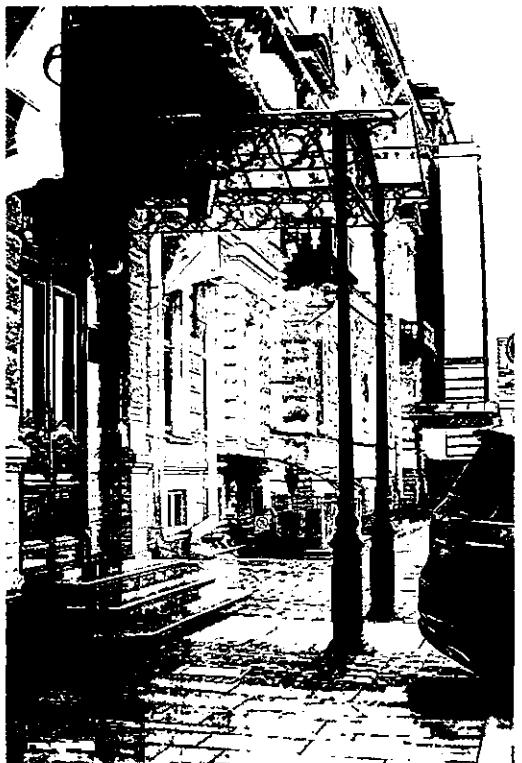
кованый ажурный козырек треугольных очертаний, поддерживаемый двумя металлическими столбами в виде стилизованных колонн;
