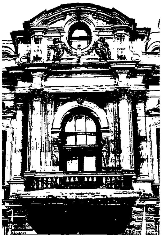
дверной проем с деревянным полусветлым филенчатым двустворчатым заполнением с порезкой и фрамугой, в профилированной раме;
