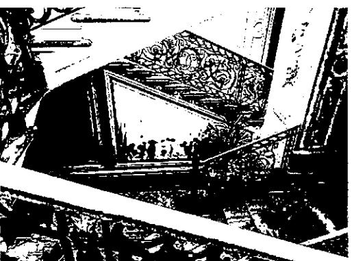
лестничное ограждение – вид материала (металл), техника исполнения (ковка), рисунок (стилизованный растительный орнамент; с позолоченными деталями, на мраморных филенчатых опорных столбах с профилированным верхним краем); поручни – конфигурация, габариты, вид материала (дерево);
