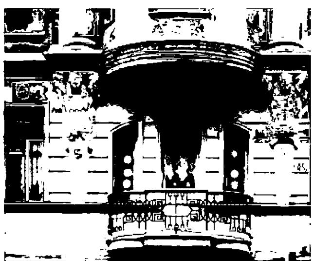
балконы – местоположение (в завершении боковых эркеров), габариты, конфигурация (трехгранные в плане), ограждение – колонны тосканского ордера на высоких постаментах с геометрическим штукатурным заполнением между ними);
