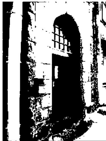
оформление дверных проемов в виде порталов: обрамления из блоков красного гранита, в том числе колотого, фигурные навершия с рельефными элементами в форме медальонов и ромбов;
