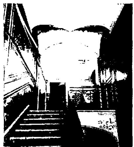
трехмаршевая межэтажная лестница (в дворовом корпусе, в южной части) - с известняковыми ступенями, ограждением черного металла (рисунок - горизонтальные тяги, вертикальные стойки с перехватами и волютообразными завитками с розетками на концах) и деревянными профилированными поручнями, на косоурах;
