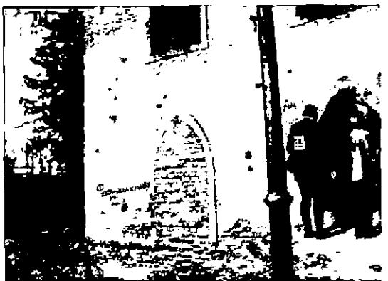
оконные проемы 2-го этажа лицевого юго-восточного фасада: местоположение, габариты, тип перемычек (арка стрельчатого очертания);
