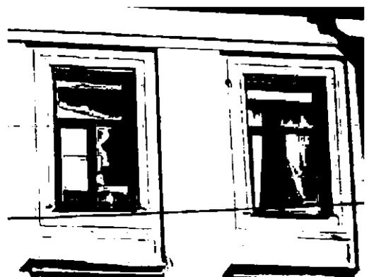
дверной проем (по 13 оси) – местоположение, габариты, конфигурация (прямоугольный), с прямоугольной нишей над дверным проемом, оформленной веерным рустом;
