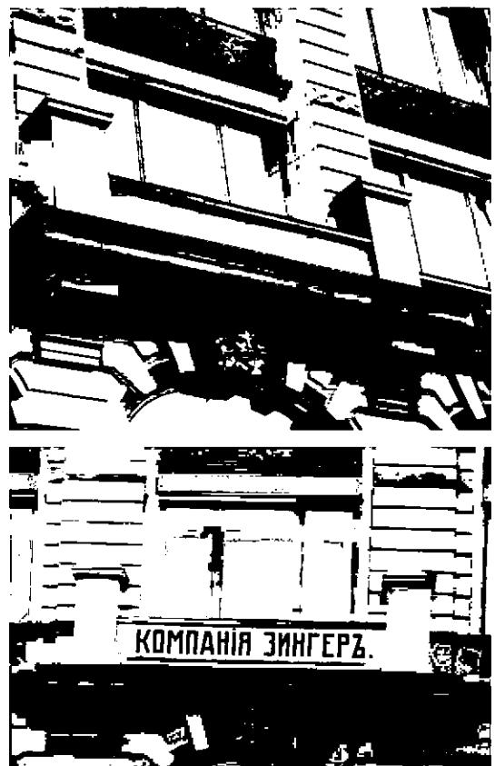
три прямоугольных в плане с закругленными углами балкона в уровне 5-го этажа южного и восточного фасадов и угловой части здания – с металлическим ограждением (ковкая бронза) растительного рисунка;
