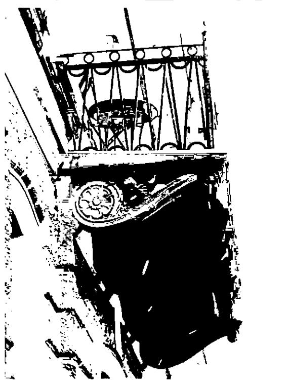
3 балкона на чугунных волютообразных кронштейнах – местоположение, габариты, конфигурация (прямоугольные в плане), материал ограждения (металл);
