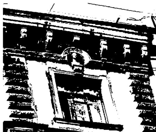
антаблемент, состоящий из профилированного архитрава, широкого фриза, заполненного поясом лепных провисающих цветочных гирлянд и профилированного карниза значительного выноса с дентикулами и иониками, опирающегося на каннелированные волкотообразные кронштейны,
