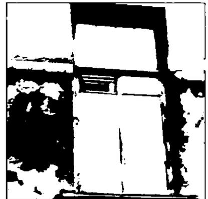
столярное заполнение проёма главного входа, выполненное в формах модерна – двупольное, с остеклённой фрамугой криволинейного очертания; створки дверей полусветлые, в нижней части по две прямоугольные фигурейные филёнки, отличные друг от друга по размерам (рисунок, материал) \*
