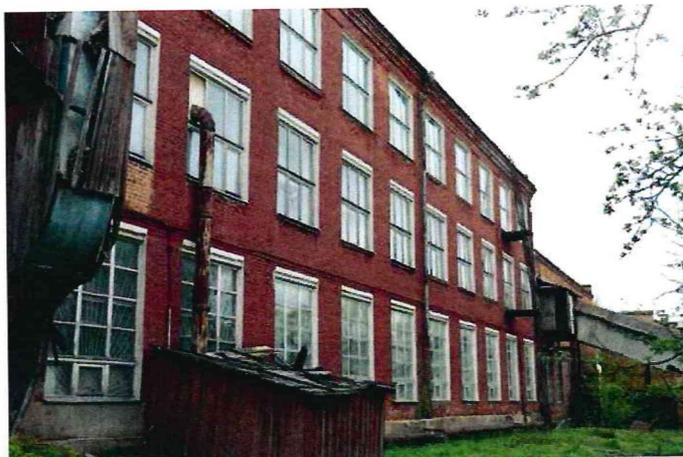
форма, габариты, конфигурация двускатной крыши, фланкируемой брандмауэрами; материал покрытия – листовой металл на фальцевом соединении (фотография 4):
