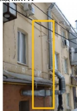
Угловая пилястра. Фрагмент восточного фасада
