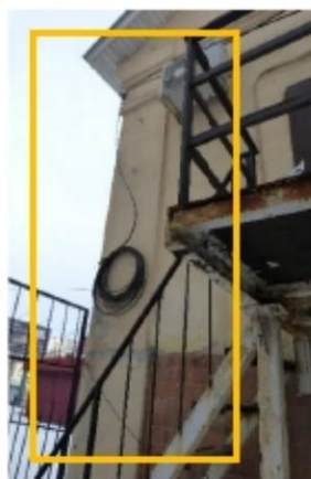
Угловая пилястра. Фрагмент восточного фасада
