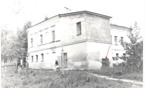
Вид с юго-востока; вход в подвал на восточном фасаде указан стрелкой, 1973 г.
