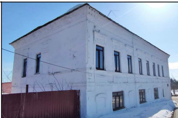
Междуэтажный и подоконный пояса на северном и западном фасадах
