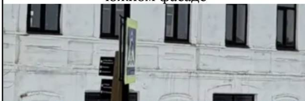
Междуэтажный и подоконный пояса на южном фасаде
