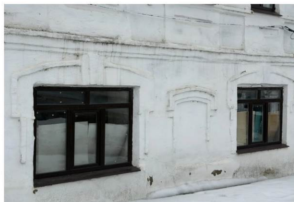
Лучковые завершения с «ушами» над оконными проемами и глухими окнами на 1-м этаже западного фасада
