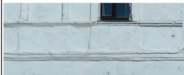
Фрагмент южного фасада с подоконным и междуэтажным поясами
