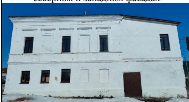
Междуэтажный и подоконный пояса на южном фасаде
