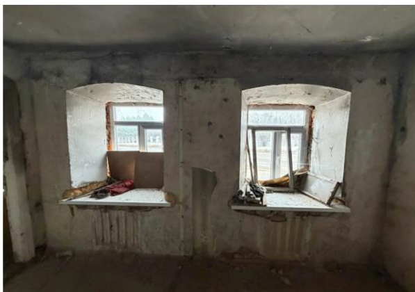
Два западных окна на 1-м этаже южного фасада: рассвет с лучковым верхом
