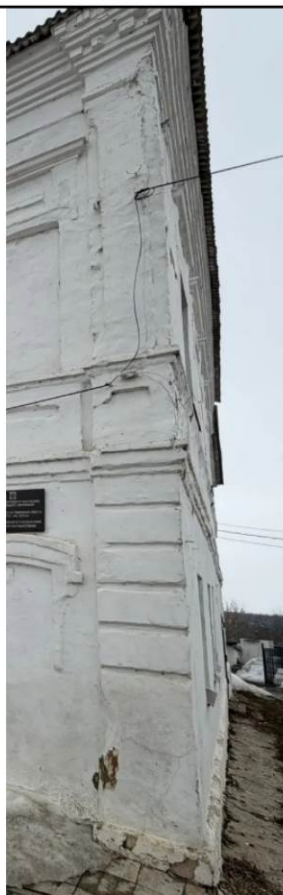
Южная угловая пилястра западного фасада
