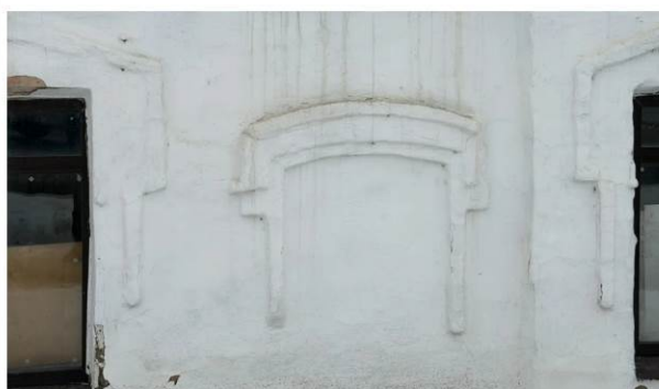
Лучковое завершение с «ушами» над глухим окном на 1-м этаже западного фасада
