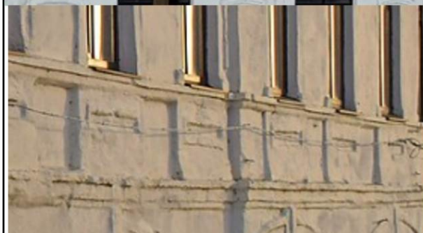
Фрагменты южного фасада с подоконным и междуэтажным поясами и филенками под проемами окон
