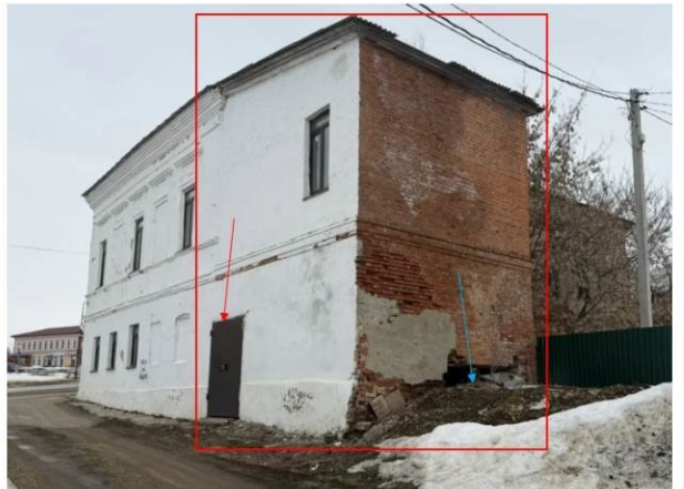
Вид с юго-востока; красным контуром выделена пристройка (лит. а), красной стрелкой указан главный вход в здание на южном фасаде, голубой - вход в подвал на восточном фасаде
