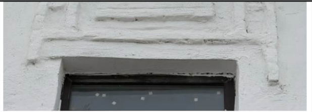
Прямой карнизный сандрик над оконными проемами и глухими окнами 2-го этажа на западном, северном и южном фасадах
