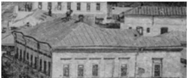
Фрагмент фотографии начала XX в.: историческая крыша д. 15 металлическая фальцевая
