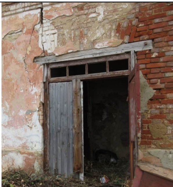
Дверной проем, кирпичная клинчатая перемычка над основным входом на южном фасаде в пристройке (лит. а), 2018
