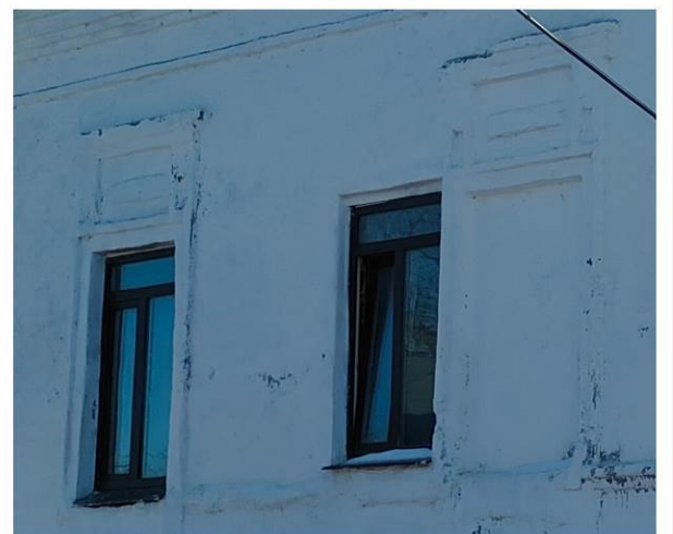
Сандрики с рамочными наличниками над оконным проемом и глухим окном 2-го этажа северного фасада, проем между ними – поздний
