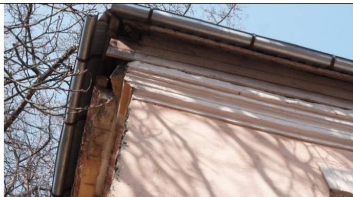
Венчающий карниз (южный угол здания)
