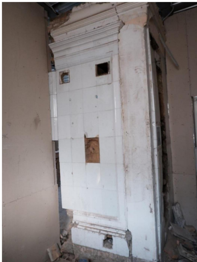
Зеркало печи в помещении №7 первого этажа (изразцы белого цвета, профилированная рамка, венчающий карниз и пьедестал, печная фурнитура)
