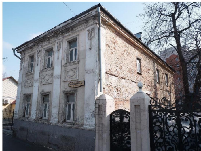
Общий вид здания (вид со стороны ул. Октябрьской)
