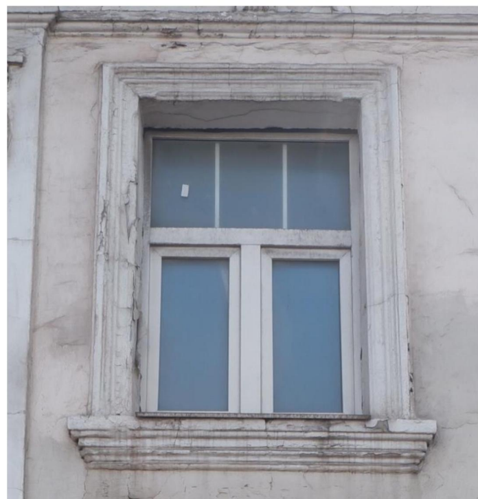
Профилированные наличники второго этажа северо-западного фасада
