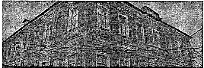
Кирпичный ступенчатый подоконный карниз 2 этажа. Вид с юго-востока
