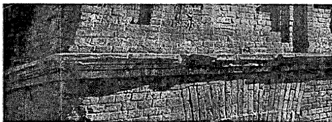
Профилированный белокаменный междуэтажный карниз над окнами цокольного этажа. Фрагмент южного фасада.
