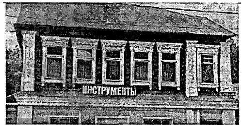
Юго-восточный фасад. Бревенчатый сруб второго этажа
