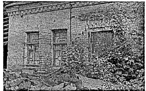
Кирпичные стены первого этажа
