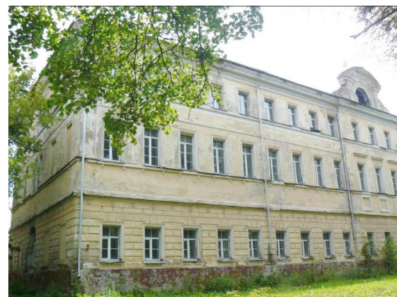
Фрагмент главного западного фасада
