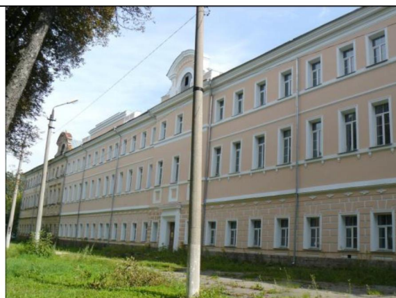
Фрагмент главного западного фасада
