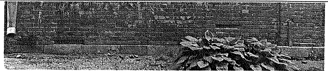
Фрагмент восточного фасада. Основание – белокаменные блоки.
