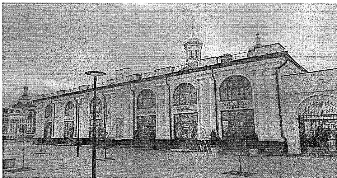
Фото 3. Вид с северо-запада
