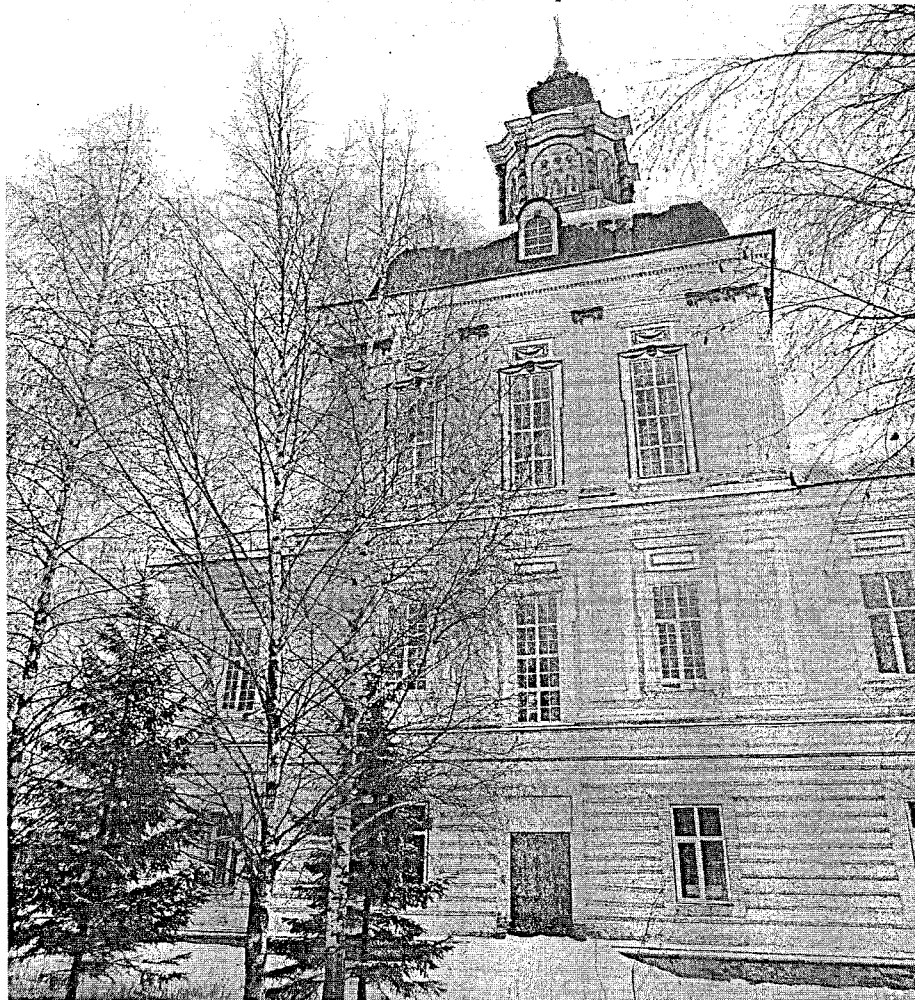
Фото 3. Фрагмент северного фасада
