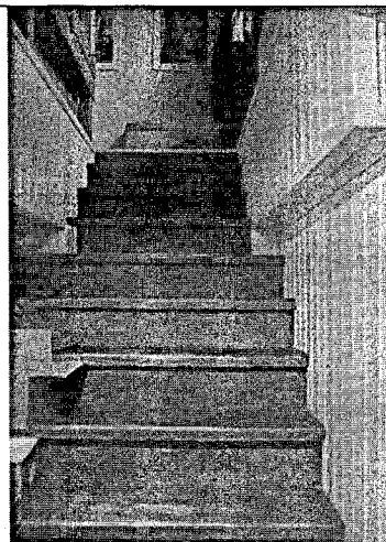
Фото 9. Лестница на мансарду
