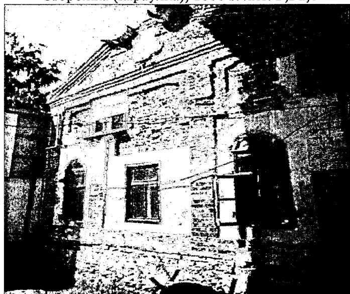
Фото 10. Фрагмент восточного фасада. Сторожка (караулка), 1866 г. лит. Б,Б1,б
