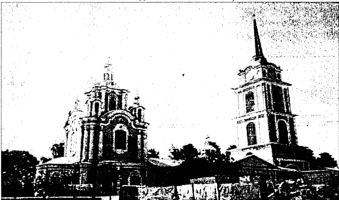
Фото 3. Вид с северо-востока лит. А,А1
