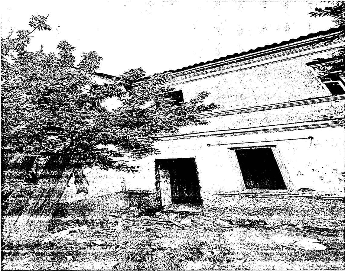
Фото 9. Фрагмент западного фасада
