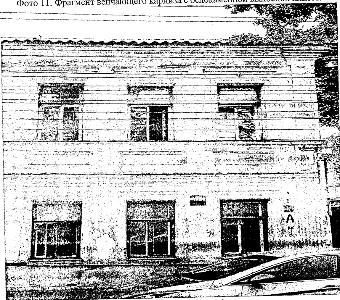
Фото 12. Фрагмент главного фасада
