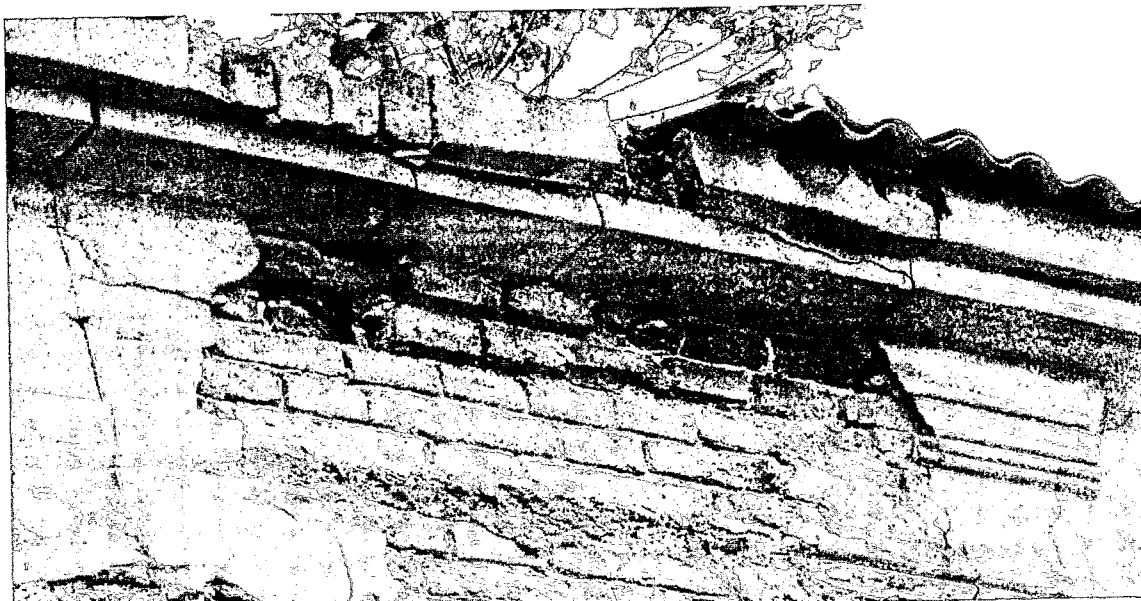
Фото 11. Фрагмент венчающего карниза с белокаменной выносной плитой
