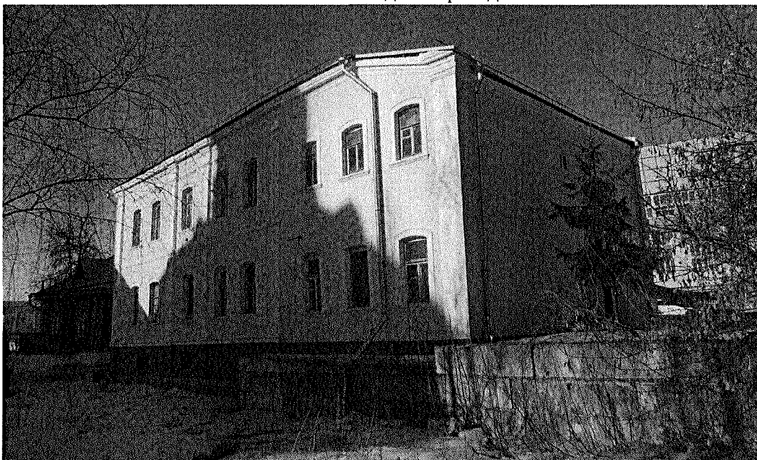
Фото 2. Вид с северо-востока
